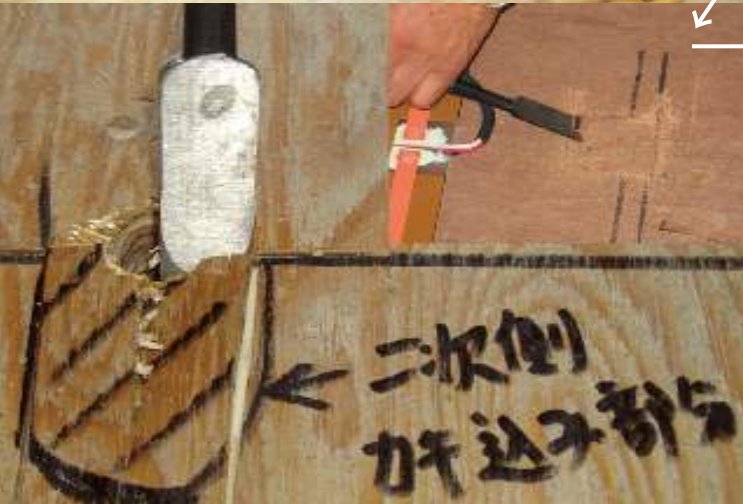
3, 縦、横 80 ミリ 深、10 ミリ 程度の溝を彫る。
