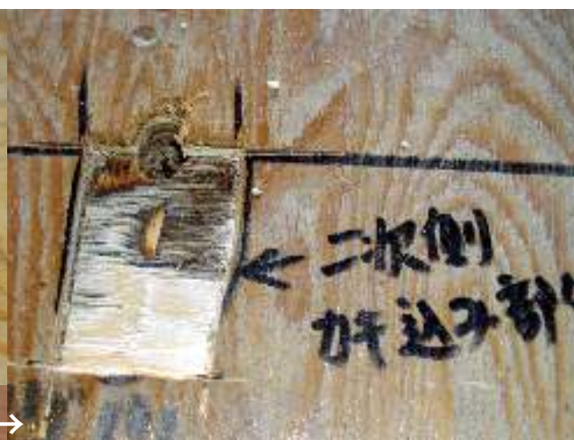
3, 縦、横 80 ミリ 深、10 ミリ 程度の溝を彫る。
