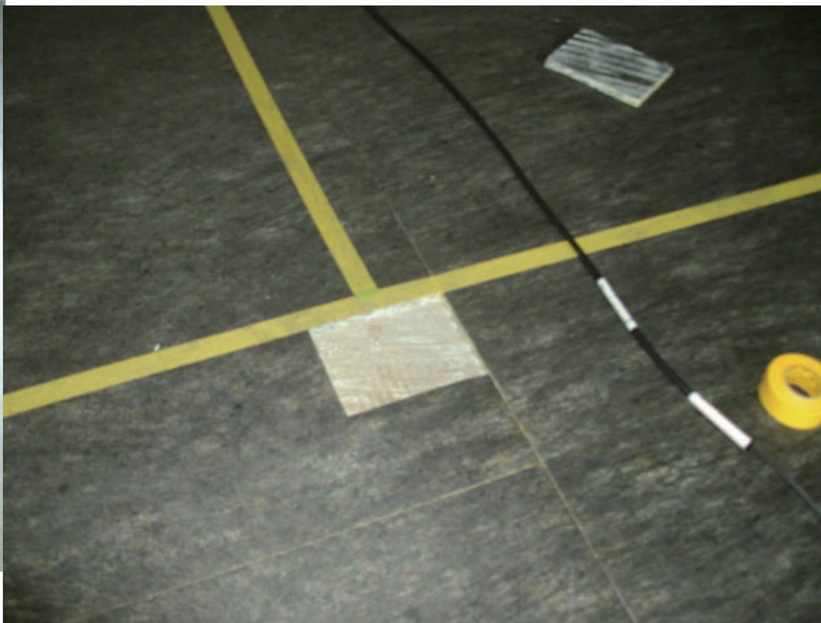
“ 暖フィルシート ” の上に、暖フィルを仮置きして墨出しをします。
